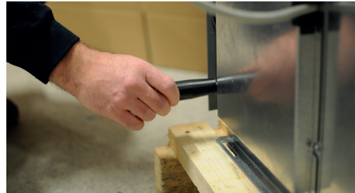
2. Fest de to bærehåndtakene i kjølemodulens nerkant.
