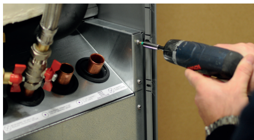
3. Skru ut kjølemodulens festeskruer.
