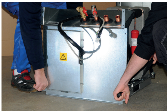
5. Løft kjølemodulen ved hjelp av bærehåndtakene og bæreremmene.
